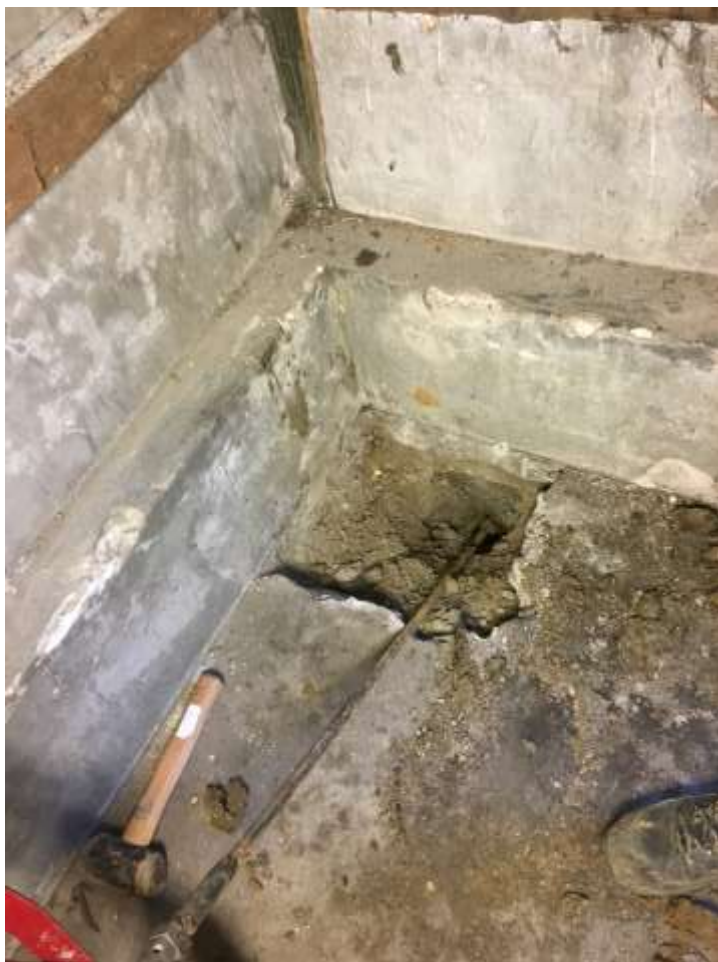
Foto 4. Prøvegravning (PG2) med håndboring igennem gulv.
