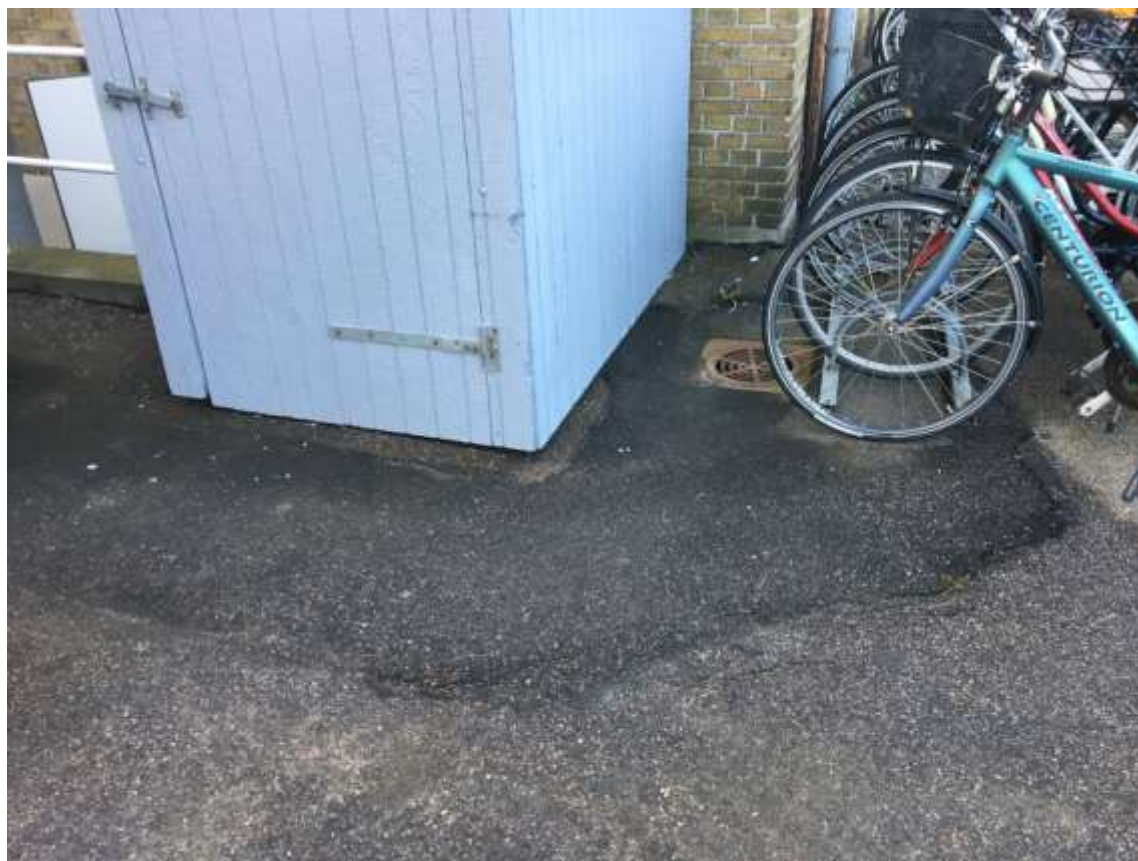
Foto 5. Det ses af nyetableret belægning, at der har været udført ledningsarbejde for nyligt.
