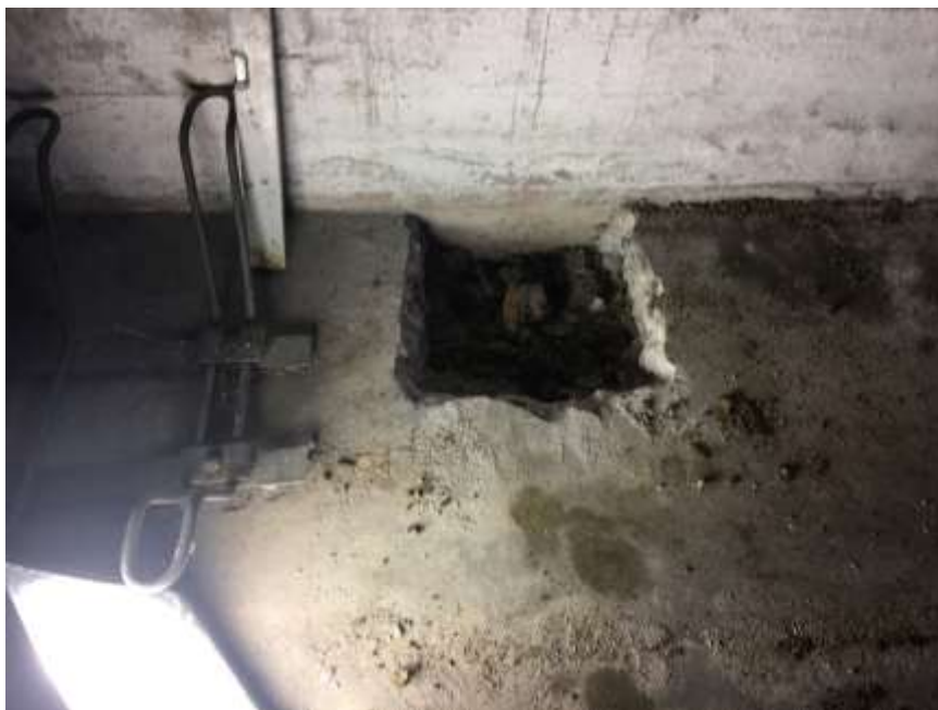
Foto 3. Prøvegravning (PG1) med håndboring igennem gulv.
